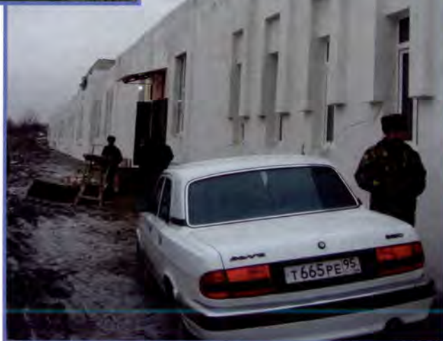
Здание АТС-24 до и после восстановления
