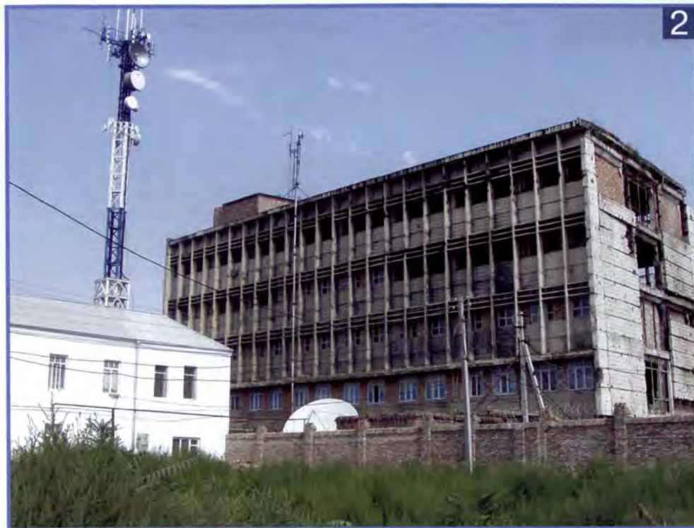
Технический корпус АМТС в г. Грозный в процессе восстановления
