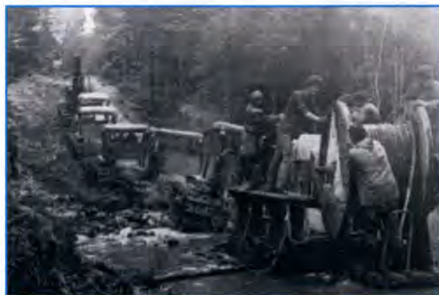
Прокладка кабельной линии на острове Куба, 1962 г.
