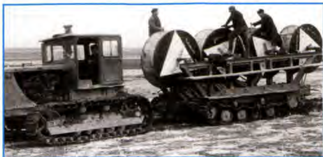
Прокладка кабельной линии связи
