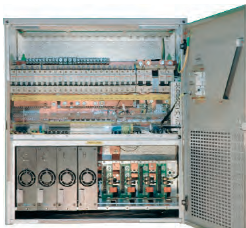
Система электропитания S94R Electro FR48-2000-8
