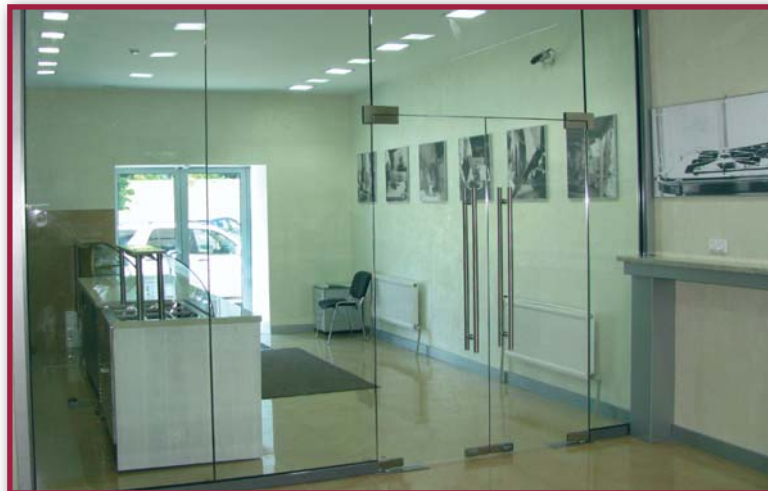
Безрамная противопожарная перегородка
