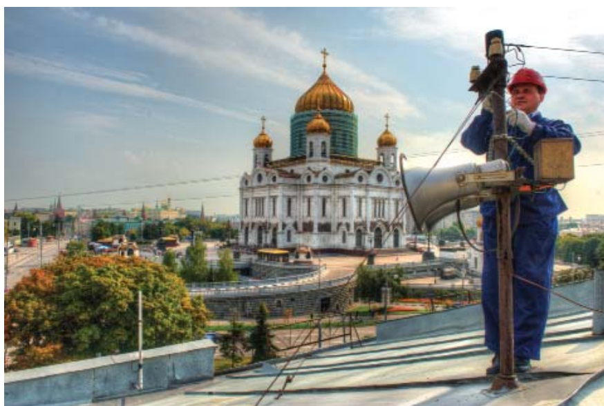
Строительство линий связи проводного вещания в Москве
