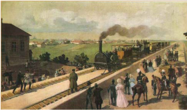
Николаевская железная дорога между Петербургом и Москвой, вдоль которой в 1851–1852 гг. была проложена подземная кабельная телеграфная линия
